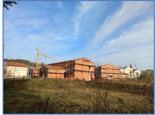
Tranche 2 en cours de travaux
